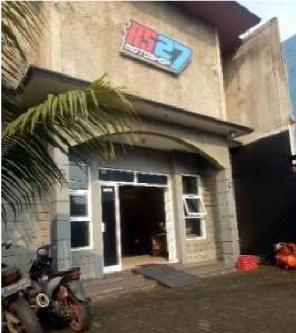
Gambar 4. Tampak Fasad Bengkel RS27 Motoshop Sumber: Penulis, 2022
