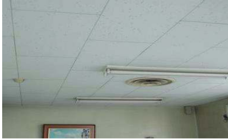
Gambar 5. Plafond (Dokumentasi : BlueScopeSTELL )
