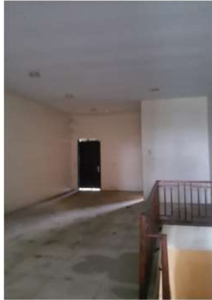
Gambar 4. Tampak Area Kafe Lantai 2 dan Resepsionist
